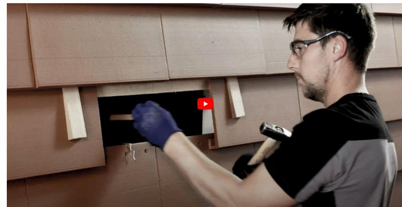
Durch die Verwendung des VERTICO-Clips ist der **Austausch einzelner Platten ohne Rückbau** der gesamten Fassade möglich. Der neu einsetzte VERTICO ist durch das Clipsystem genauso kraftvoll mit der Unterkonstruktion verbunden.
